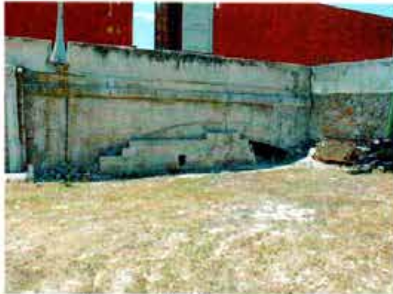
Arranque del viaducto en la playa
