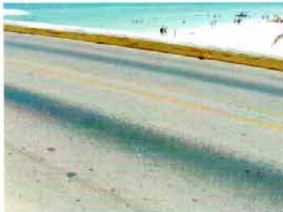
Pavimento, sección inicial. Buen estado
