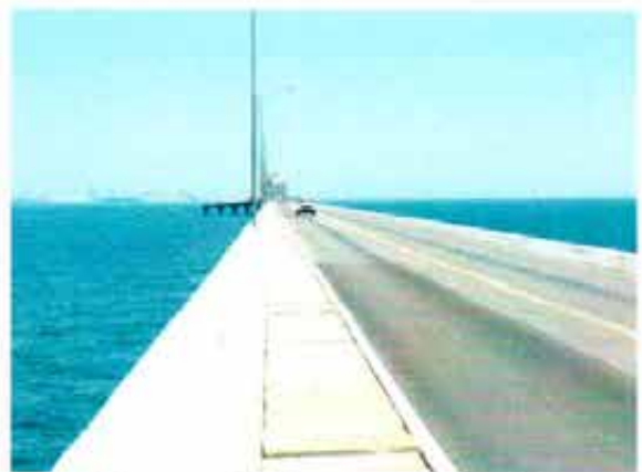
Nueva sección de pavimento reparado
