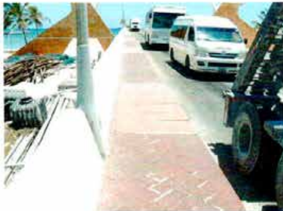
Comienzo de viaducto. Banqueta pavimentada inicialmente
