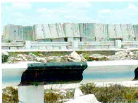
Parapeto metálico y escollera
