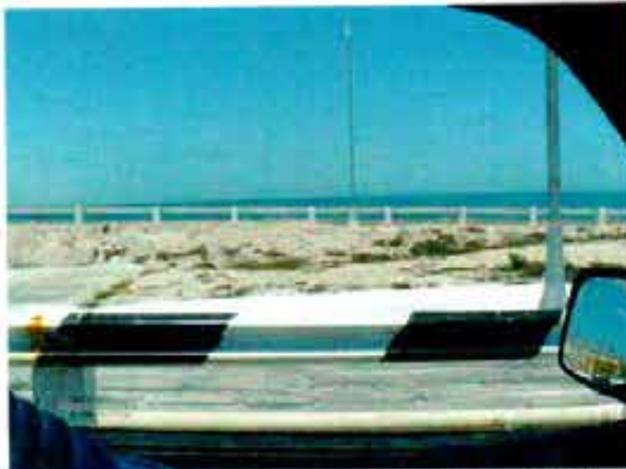
Calzadas separadas a partir de oficinas de API
