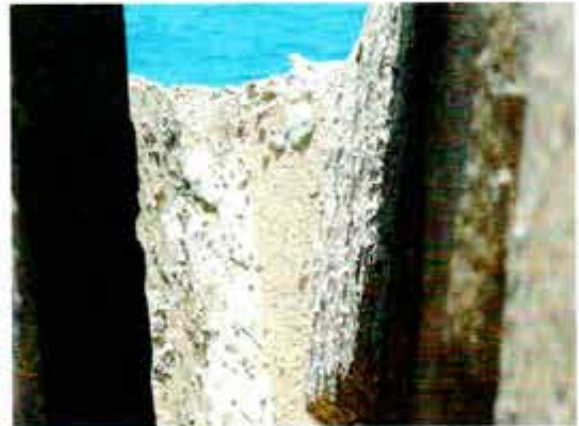
Detalle de escollera de bloques escollera
