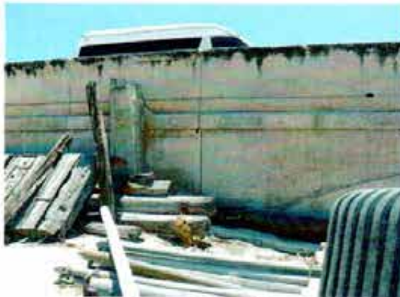
Primeros arcos casi enterrados
