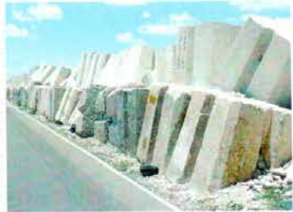
Escollera próxima a sección de llegada de viaducto nuevo
