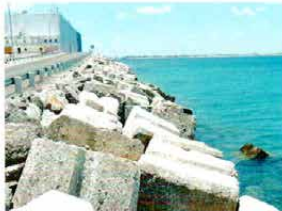
Escollera en punto de posible llegada
