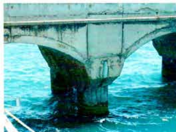
Detalle de pilas y cabozales
