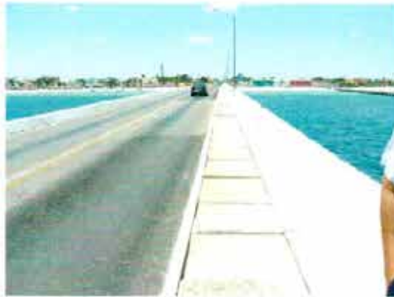
Pavimento reparado y galería de servicios
