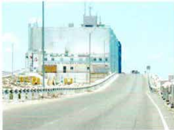
Oficinas de API. Ductos de PEMEX
