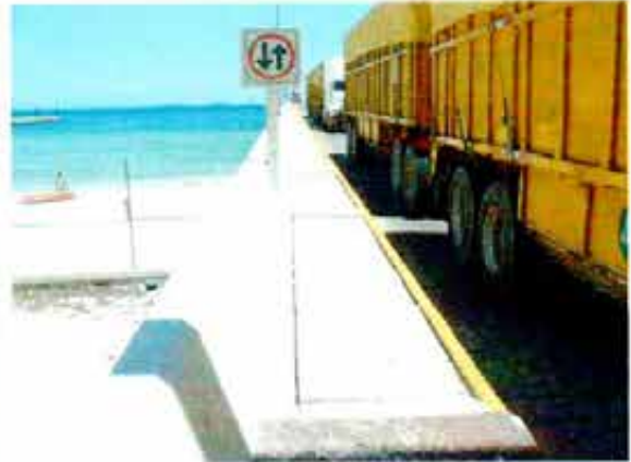
Comienzo de galería de servicios. Parapeto
