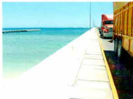
Tránsito sobre viaducto. Carriles algo estrechos
