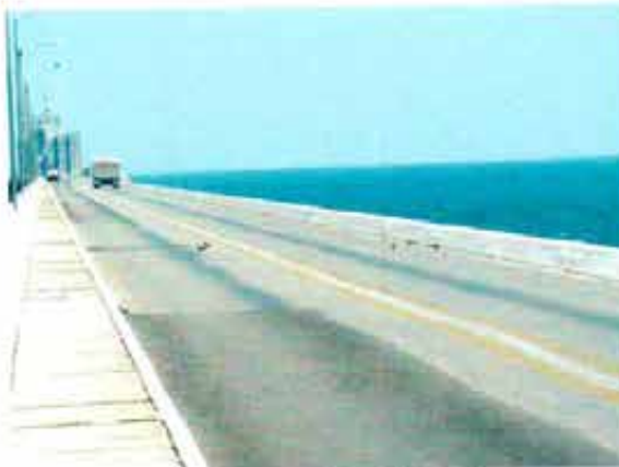
Vista de la sección del viaducto
